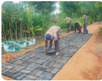
► Pose des derniers pavés du parcours
