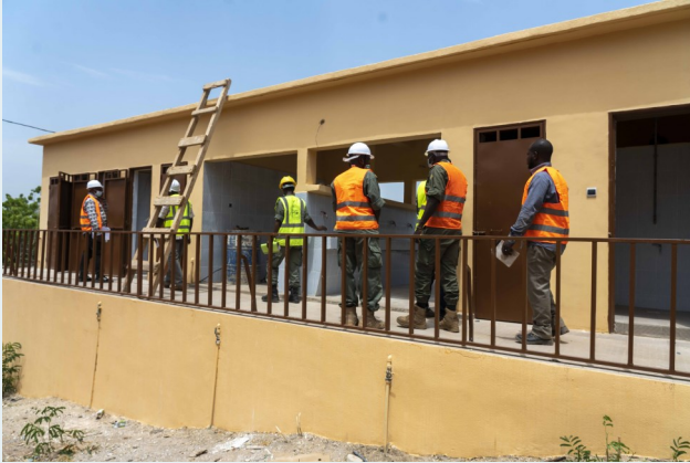
Visite de chantier au Prytanée militaire de Kati
