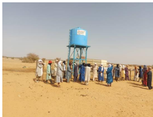
Réception du château d'eau par les bénéficiaires
