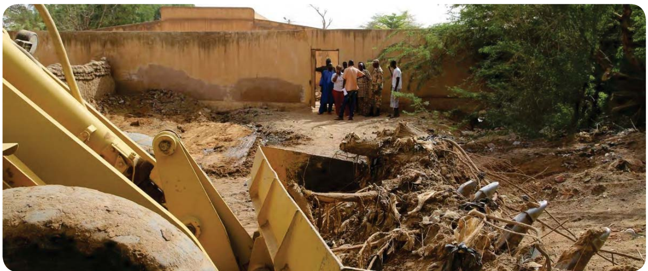
La prison de Douentza en cours de réhabilitation
