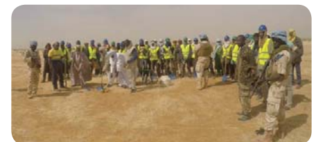
Les travaux commencent sur le site de cantonnement de Fafa en décembre 2015
