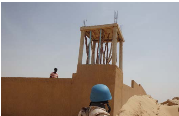
Travaux de sécurisation additionnels en cours au camp de cantonnement de Ber
