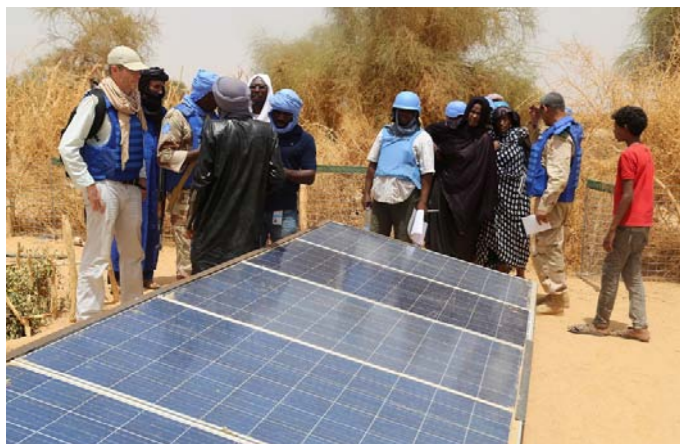
Installation du panneau solaire pour l'alimentation du forage
