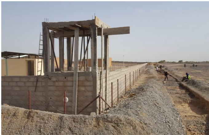
Travaux de sécurisation additionnels en cours au camp de cantonnement de Tessalit
