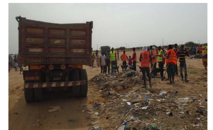
Nettoyage dans les quartiers de Gao
