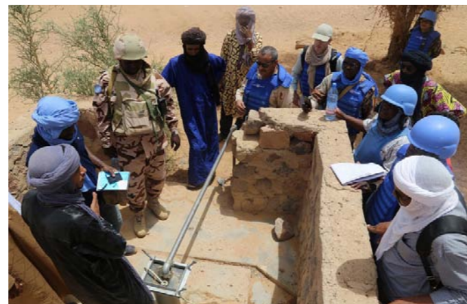
Forage d'alimentation du reservoir d'eau
