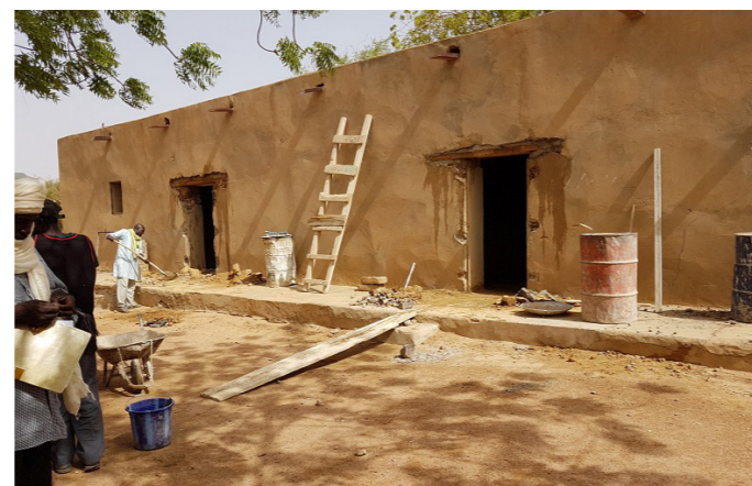
Travaux de construction en cours au Camp 1 du MOC de Kidal
